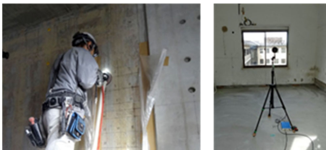
写真 1 目荒らし工法 (湿式) (左), 騒音・振動測定 (右)
